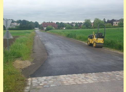
Bei der **Sanierung der Berggasse** wurden alle Zuleitungen in die Erde verlegt und die Straße konnte verbreitert und mit Gehsteigen versehen werden.
