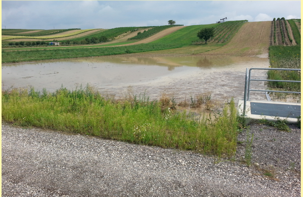
Die aufgestauten Oberflächenwässer beim Hochwasserschutz Lussberg am Tag nach den Unwettern.
